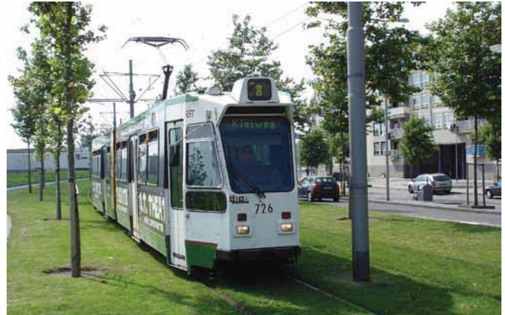
trambaan aangelegd in grasstrook, Rotterdam
